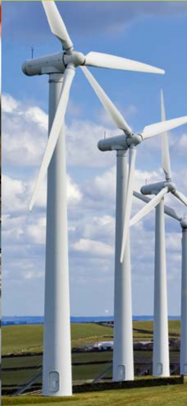
CONSTRUCCIÓN DE MÁQUINAS E INSTALACIONES
